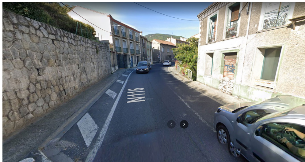
Figure 4 : zébras interdisant le stationnement avant la section étroite de la RN116
