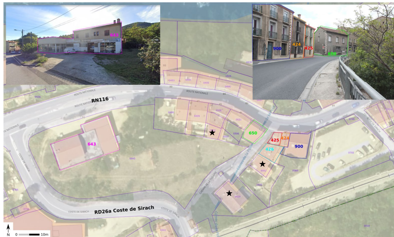
Figure 11 : localisation et photographies des bâtiments à détruire
